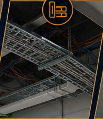
KABLO KANALI MONTAJI
